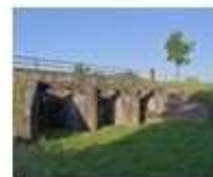
16. Inundatiesluis zuidelijke Beemsterdijk
