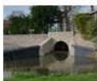
14. Sluis polder Burghorn
