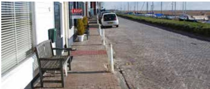
Karakteristieke opbouw: gevel - stoep - rijweg - tuimelkade
