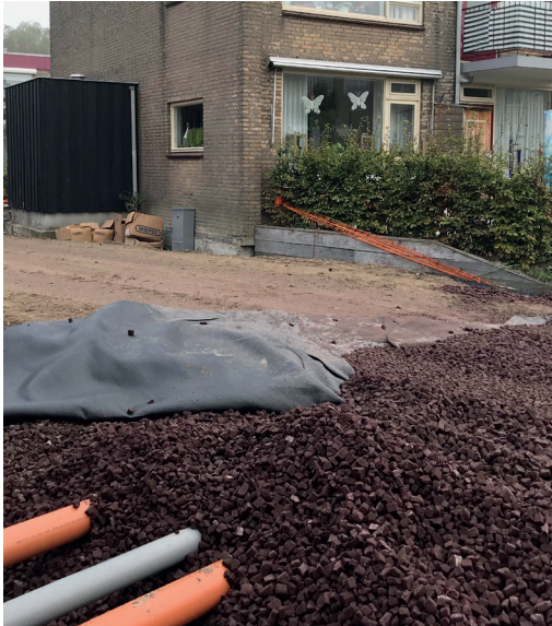
Voorbeeld aanbrengen licht ophoogmateriaal Geocell Red
