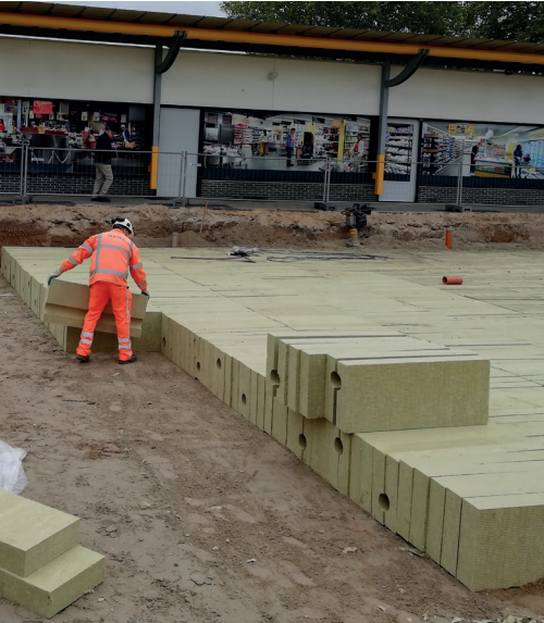
Voorbeeld aanbrengen licht ophoogmateriaal Rockflow
