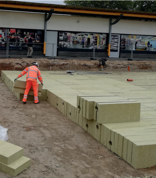
Voorbeeld aanbrengen licht ophoogmateriaal Rockflow
