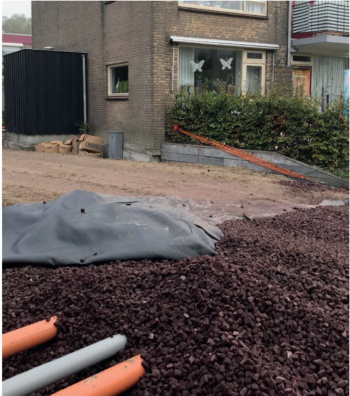
Voorbeeld aanbrengen licht ophoogmateriaal Geocell Red
