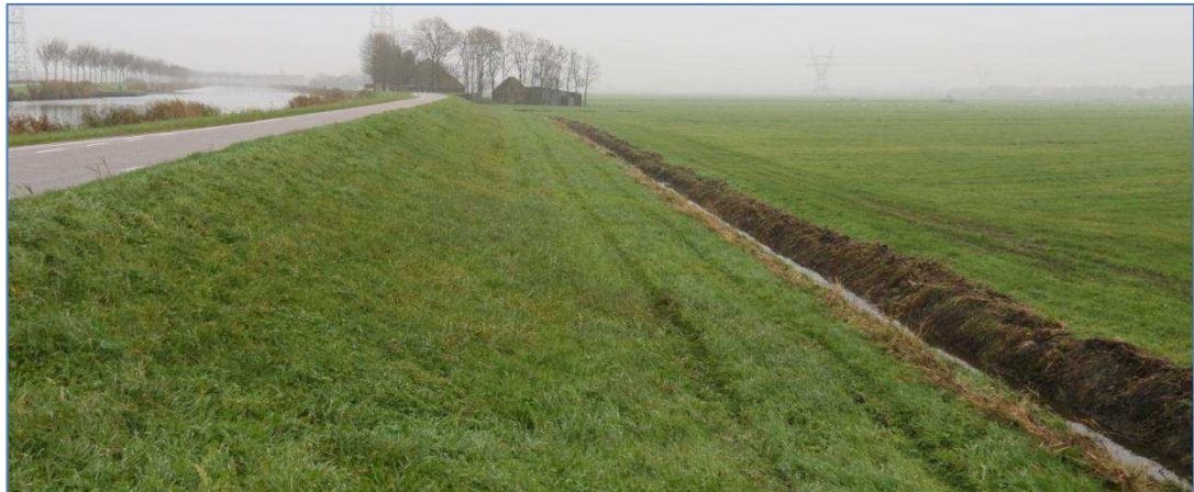
Afbeelding 5. Impressie sectie 2. Steil dijktafval met asfalt dichtbij de smalle teensloot.
