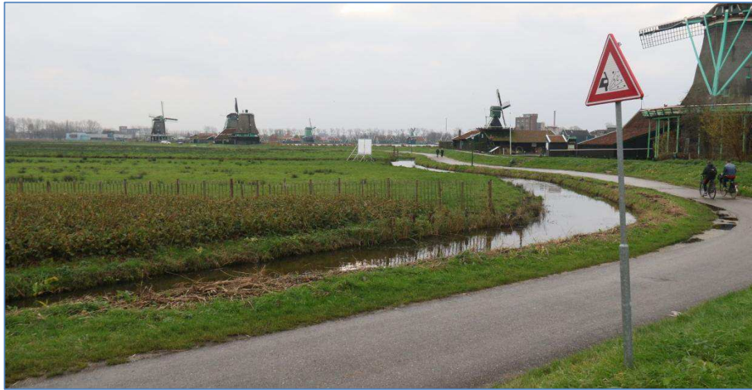
Afbeelding 16. Impressie sectie 12. Smalle dijk met smalle berm naast asfalt.
