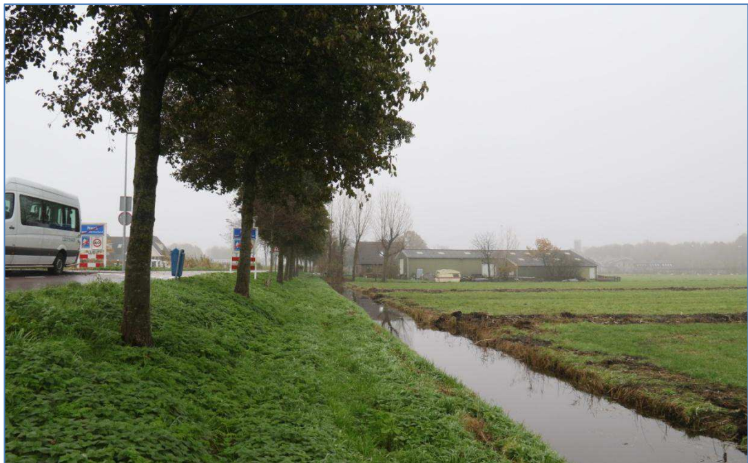
Afbeelding 9. Impressie sectie 3. Steil dijktaalud met rijbeplanting van elzen, overzijde teensloot open.
